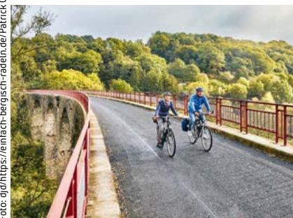
Das Viadukt Ruhrstraße Süd auf dem Panorama-Radweg „niederbergbahn“ ist nur eines von vielen auf den alten Bahntrassen im Bergischen Land.
