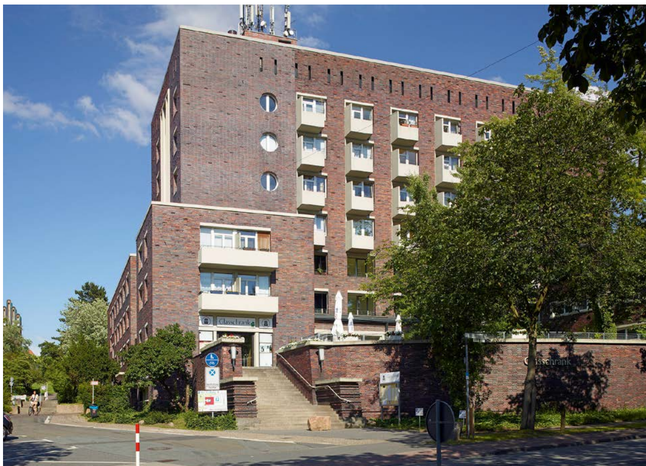
Das ehemalige Ledigenwohnheim in der Pützerstraße, Foto: Nikolaus Heiss
